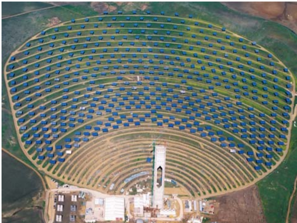
Figure 8 – Vue aérienne de la centrale PS10
