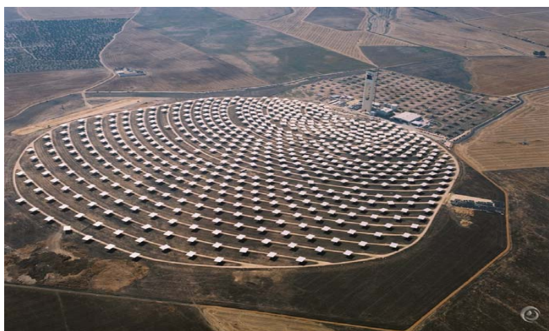
Figure 5 – Centrale PS10 de Sanlúcar La Mayor – Espagne (Photo in « Rapport technique de la commission européenne NNE5-1999-356 » de 2006.)
