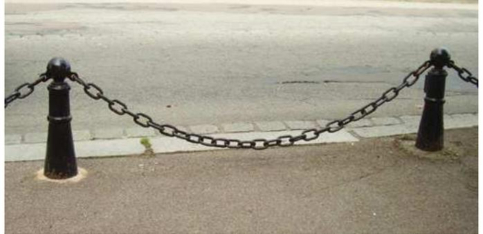
On montre en sciences physiques que, pour que cette chaîne ait une tension minimale aux extrémités, il faut et il suffit que le réel  $a$  soit une solution strictement positive de l'équation  $(x - 1)e^{2x} - 1 - x = 0$ .
