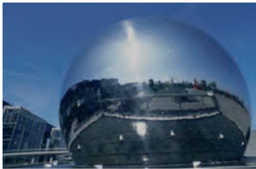
Le dôme de la Villette (1730 triangles et 36 mètres de diamètre), et un dôme plus petit.
