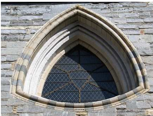
Fenêtre de l'église Notre-Dame de Bruges en Belgique
